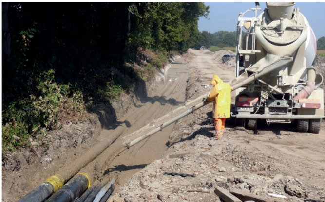
Abbildung 1: Grabenverfüllung mit ZFSV (Quelle: AGFW)
