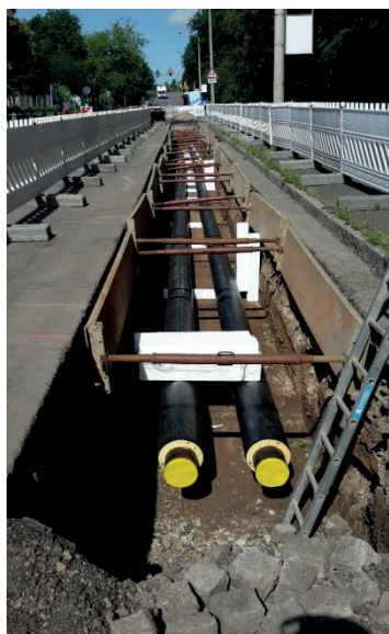
EFRE Pilotprojekt Erfurt 2013 - 2020 Ausbau der Fernwärmeversorgung in den Quartieren Borntal und Blumenviertel (Quelle: SWE)
